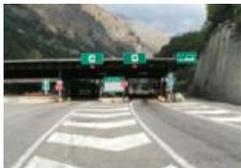
Su entrambi i piazzali sono presenti due portali termografici per ridurre il rischio di incendio di veicoli pesanti in galleria. Quando il sistema rileva la presenza di una condizione termica potenzialmente pericolosa, esso allerta automaticamente gli operatori e gestisce i sistemi di controllo del transito.
