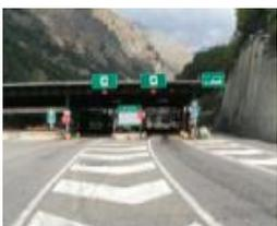
Su entrambi i piazzali sono presenti due portali termografici per ridurre il rischio di incendio di veicoli pesanti in galleria. Quando il sistema rileva la presenza di una condizione termica potenzialmente pericolosa, esso allerta automaticamente gli operatori e gestisce i sistemi di controllo del transito. Nel secondo semestre sono iniziati i lavori di rinnovo dei portali con l'integrazione di un sistema di rilevazione dimensionale e peso dei veicoli pesanti
