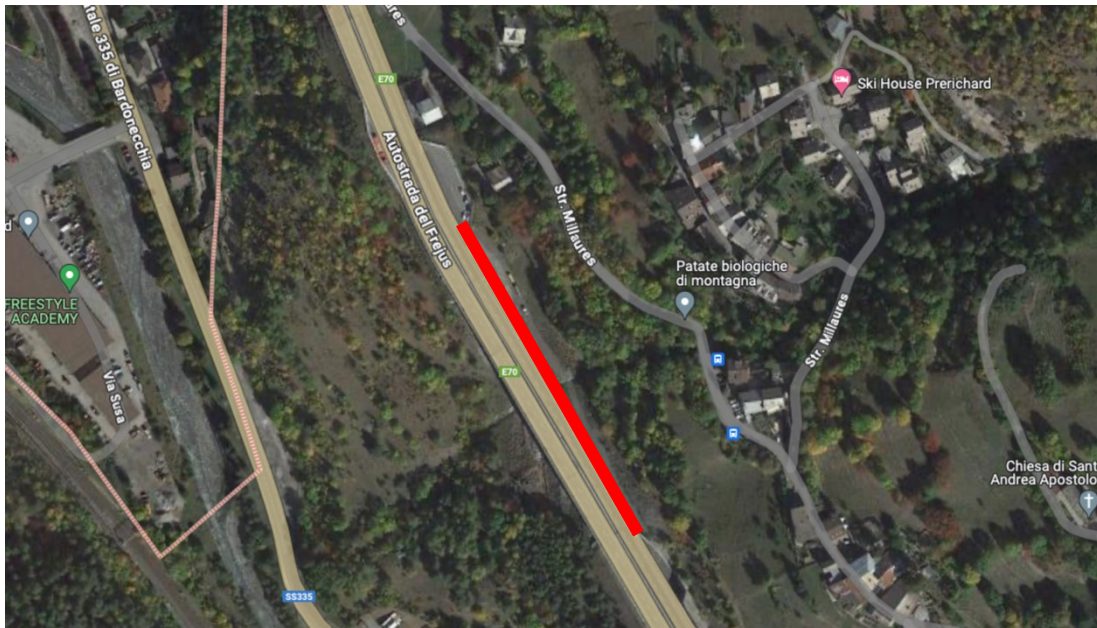
Fig. 4 - Comune BARDONECCHIA_viadotto Pré Richard
