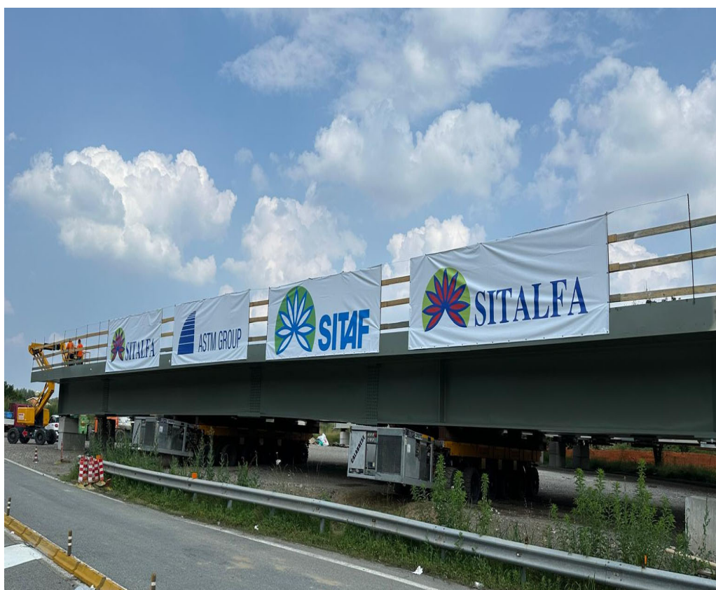
Tratta A32 – Ricostruzione ed adeguamento sismico viadotto S.S. 25 a Rivoli (TO)
